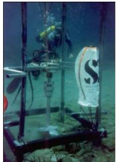
Etape intermédiaire de pose d'une ancre hélicoïdale avec dispositif hydraulique (Neptune Environnement 1999)
